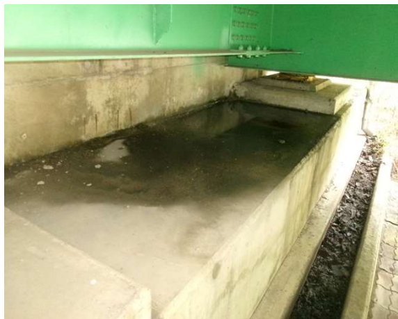
위 치 교대 상주방향 A1 현 황 체수 (A=5.0m×1.0m)
